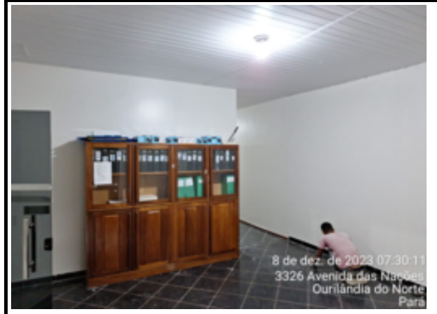
FOTO 07 Sala de Espera DATA: 08/12/2023
