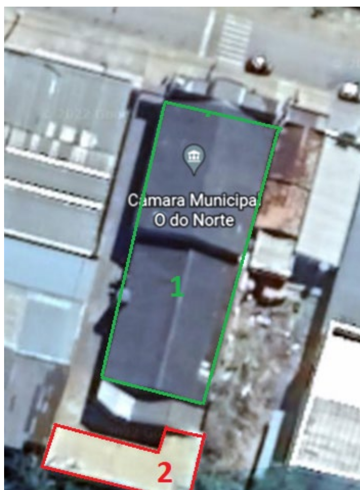
Figura 1 – Cobertura da Câmara Municipal de Ourilândia do Norte Fonte: Google earth
